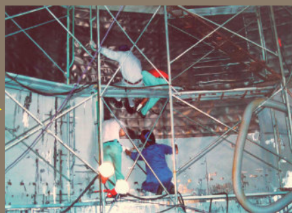
② 貯槽 内面施工
