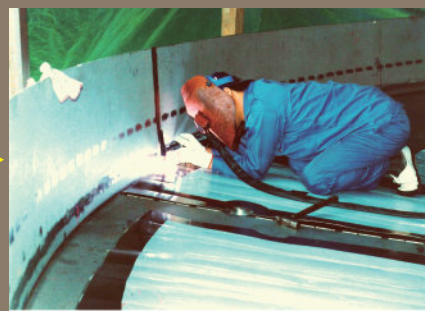
③ 蓋 内面施工
