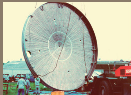
④ 蓋板取付
